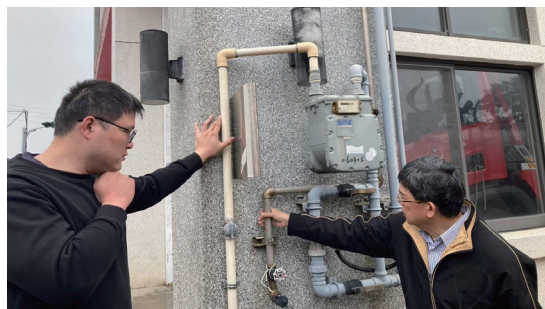
圖 2、職安輔導團隊查看設在戶外的管路（照片由新竹市消防局提供）
